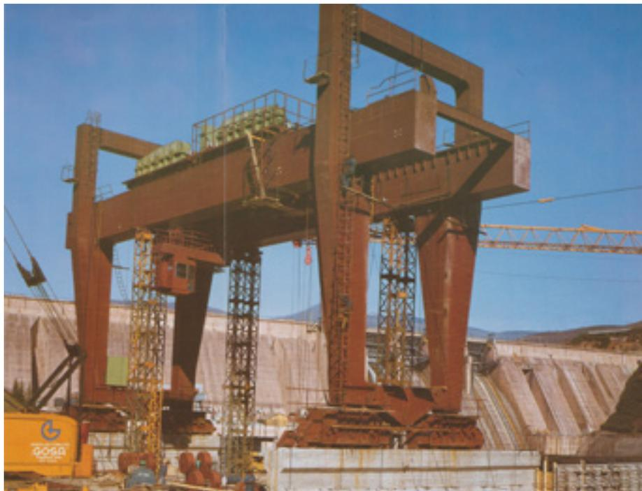
\* Реверсивная ГЭС Баина Башта - Козловой кран 2x250 т в процессе монтажа
