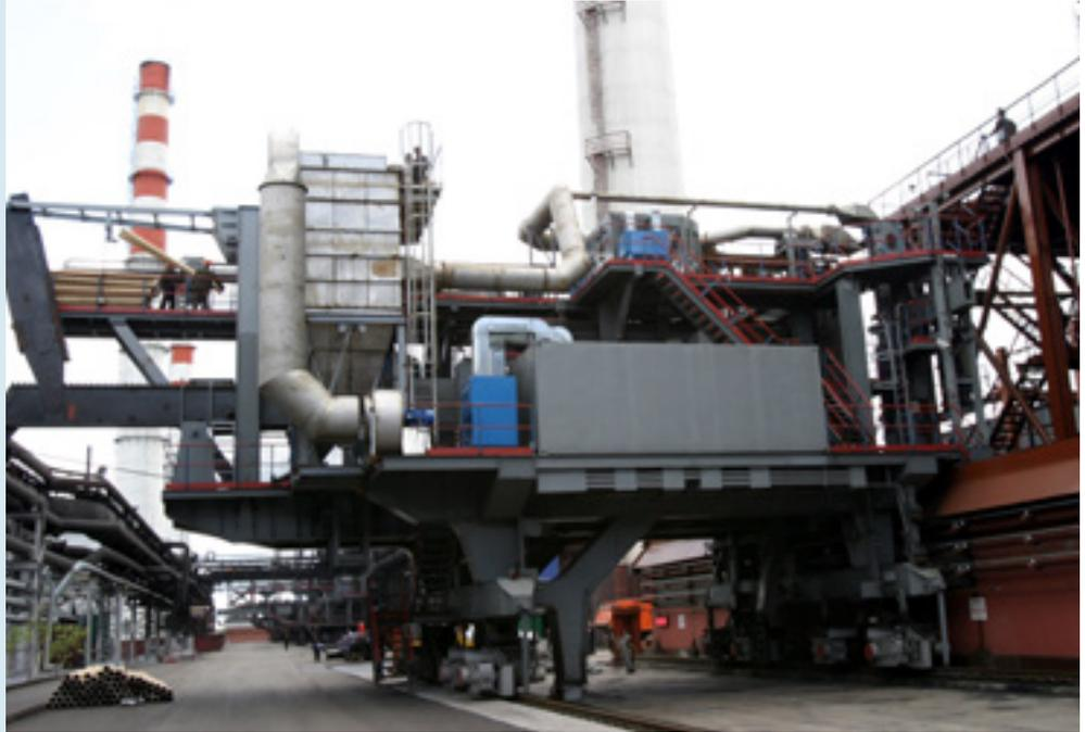
\* Пылеулавливающее устройство и чистка угольной пыли во время съема двери коксовой батареи, чистка дверей и рам при выталкивании кокса, 42,9 м<sup>3</sup> ОАО «Кокс», Кемерово
