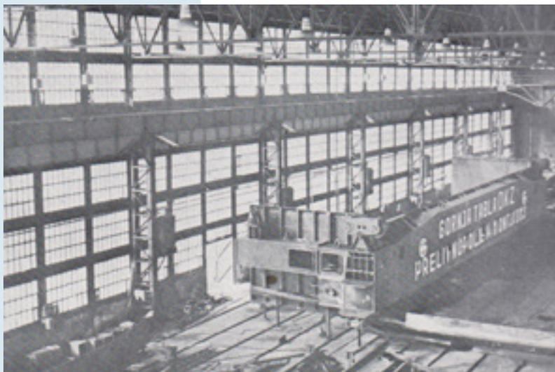
\* ГЭС «Джердап» - двойные крюкообразные затворы - верхняя секция на этапе пробного монтажа
