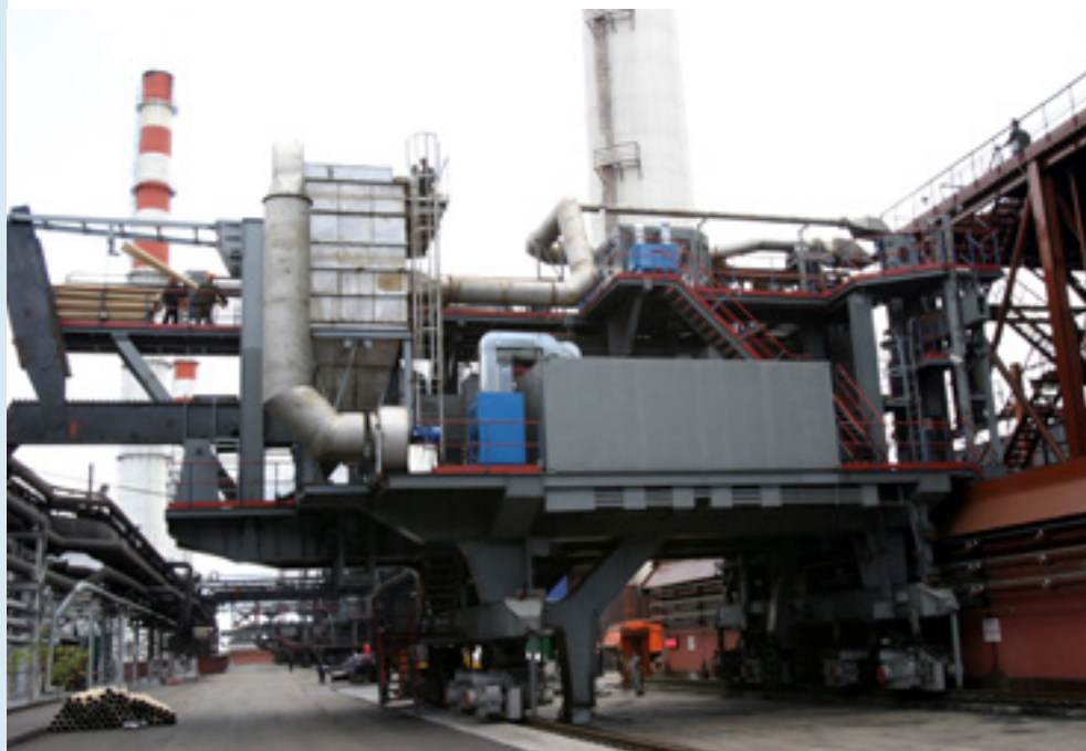
* Систем скупљања прашине и чишћења угљене прашине при скидању врата коксне батерије и чишћењу рама и врата при изгуривању кокса, 42,9 м 3 , ОАО „Кокс“, Кемерово
