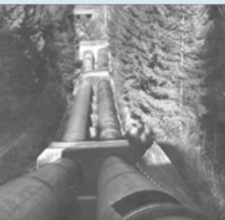
* Испитивање цевовода воденим притиском, РХЕ „Бајина Башта”
