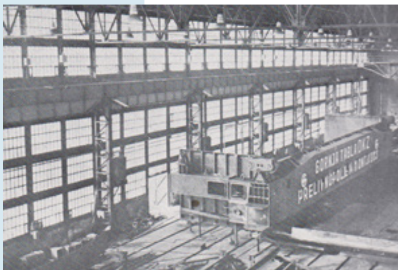
* Хидроелектрана Ђердап – двоструко кукасти затварач – горња секција у фази пробне монтаже
