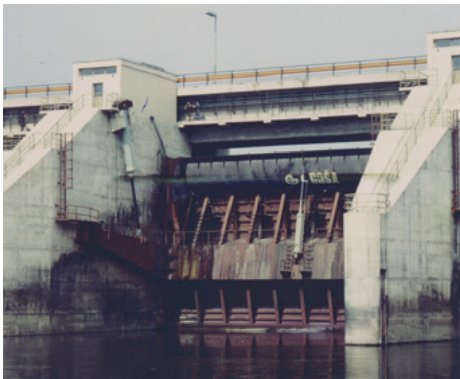
* ХЕ „Чаковец”, сегментни затварач с клапном
