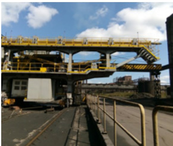
* Изгуривач кокса у монтажи, АО „Mittal Steel” – Темиртау, Казахстан
