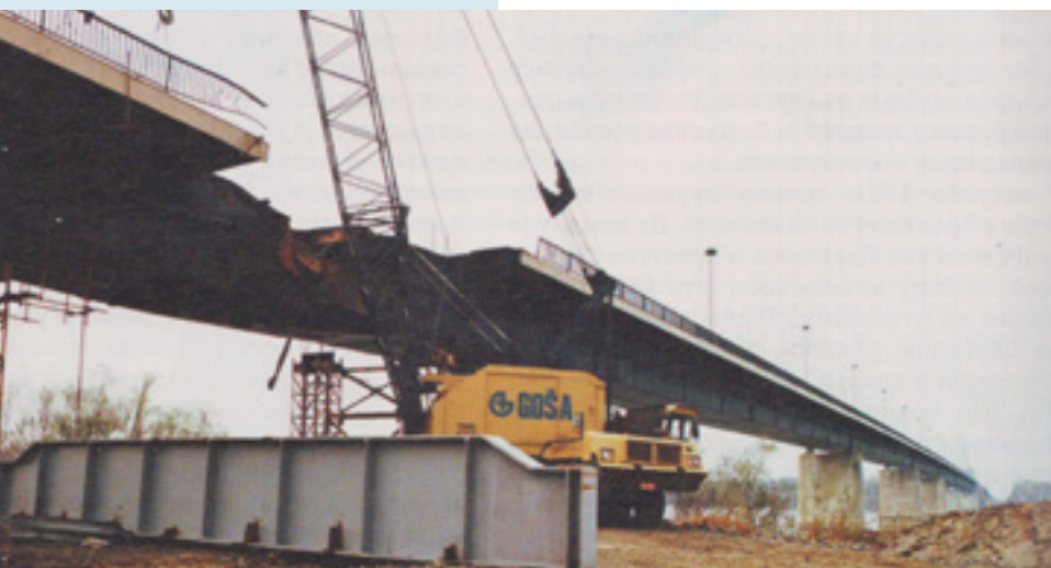
* Обнова порушеног моста Ковин на Дунаву код Смедерева
