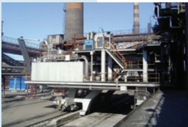
* Изгуривач кокса 35.6м 3 , ОАО „ЗСМК”
