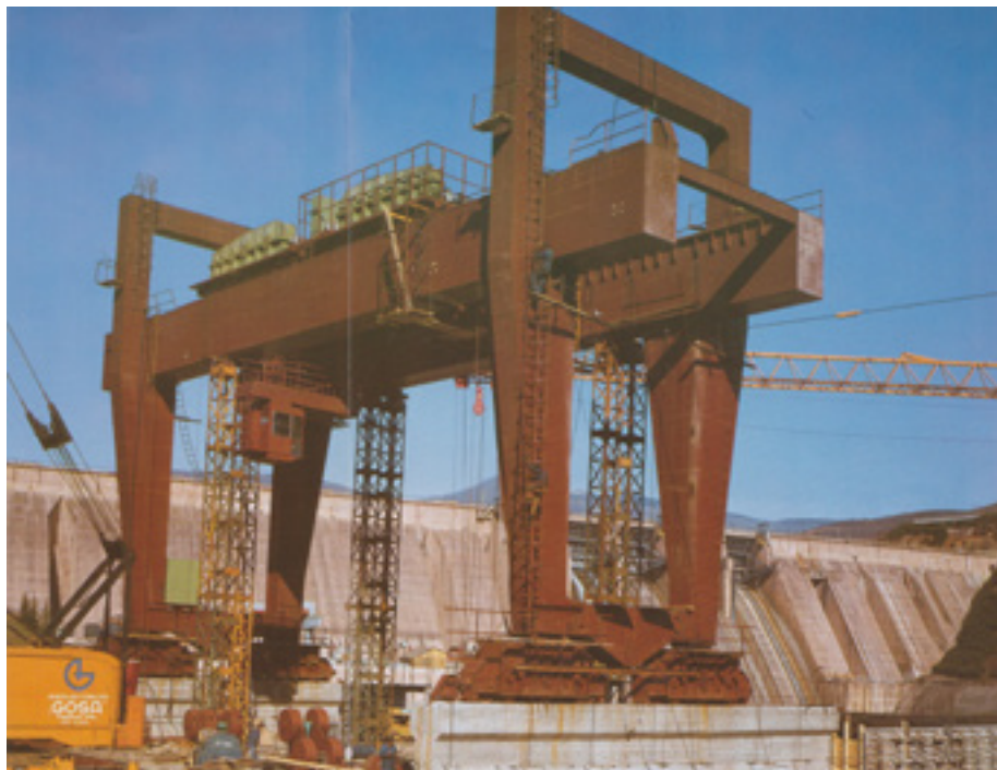
* PHE „Бајина Башта” – портална дизалица носивости 2 x 250 тона у монтажи
