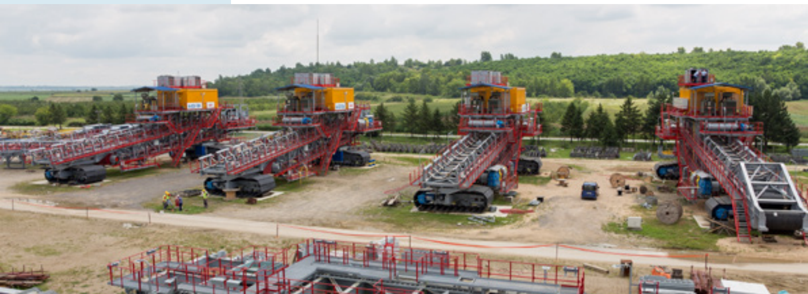
* Погонска станица В2000 на монтажном плацу „ПК Дрмно”
