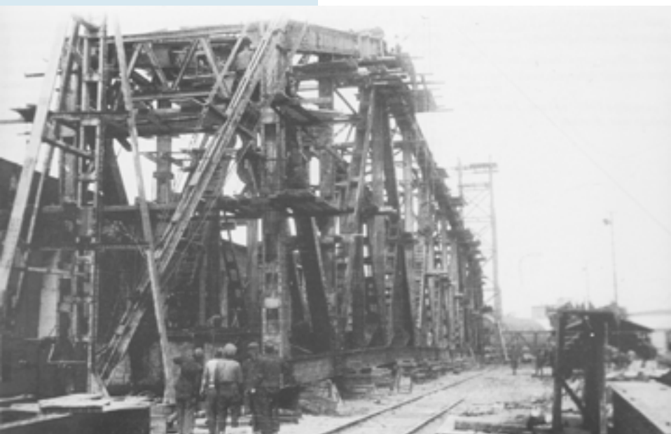
* Пробна монтажа Богојевског моста на Дунаву
